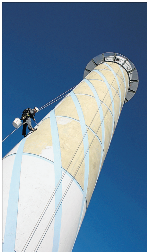
Schlot am Wiener SMZ-Ost: Höhenarbeiter am Seil am Werk. [Industrial Alpinists Vienna]
