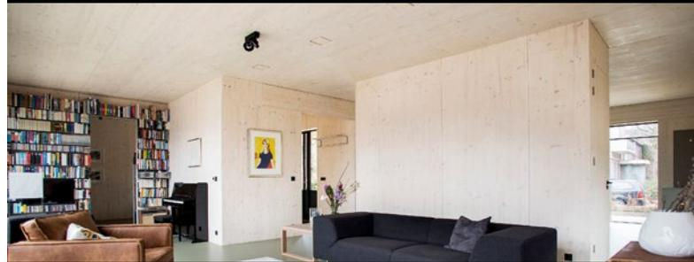
**Eine individuell konfigurierbare Systembaulösung aus vorgefertigten Massivholzkomponenten für den mehrgeschossigen Wohnbau.**
